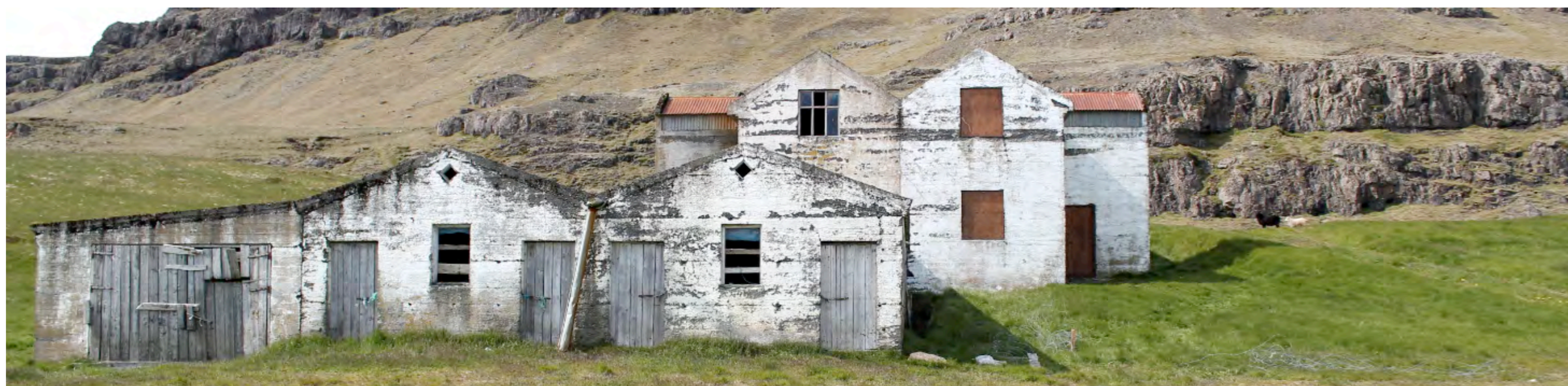
AFLÖGÐ FJÁRHÚS Í ENDURBYGGINGU
